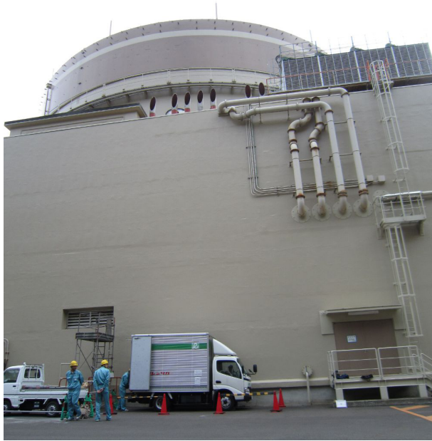
図 6.2: トラックに積載した状態で関西電力大飯発電所に設置された PANDA36
